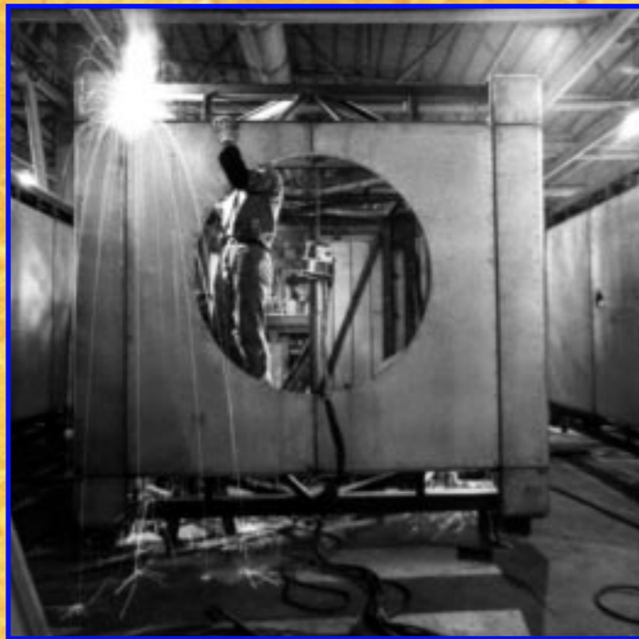
Un ouvrier soude la structure d'une capsule préfabriquée. Usine Aina Koki, Maibara, Préfecture de Shiba, 1971.
